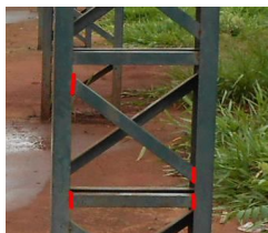
Vista do módulo considerado. Detalhe dos pontos de solda
